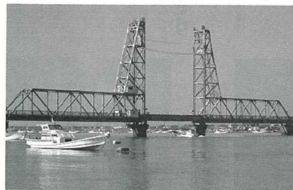
筑後川昇開橋
