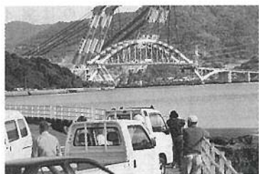
橋げたに取り付けられる巨大なアーチ部分＝伊万里湾で
