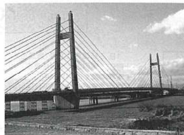
筑後川にかけられた斜張橋・天建寺橋
