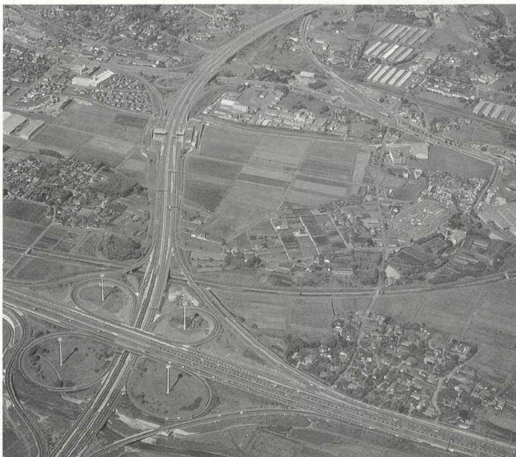
四つ葉のクローバー型の 鳥栖ジャンクション
