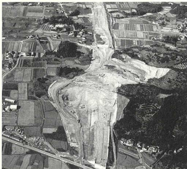
【写真説明】 姿をみせてきた九州横断自動車道 ルート
